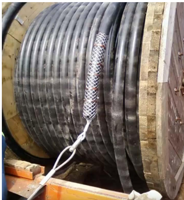
Рисунок 1 – Протяжка кабеля с использованием кабельного чулка
